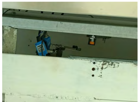
回旋加速器防护门上方联锁装置
