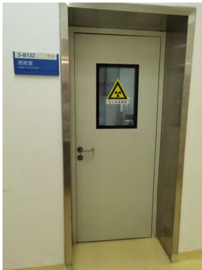
质控室入口防护门
