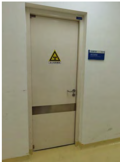
成品通道入口防护门
