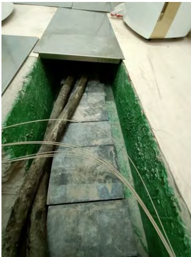
地面管线沟槽
