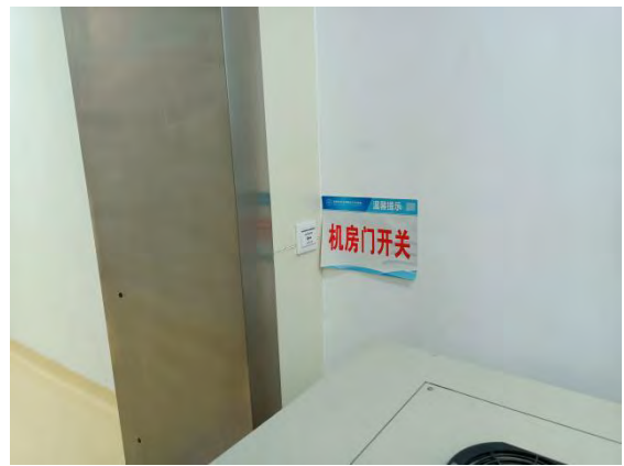
回旋加速器机房内门控开关
