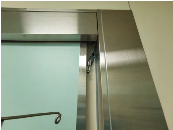
患者进出防护门上方联锁装置
