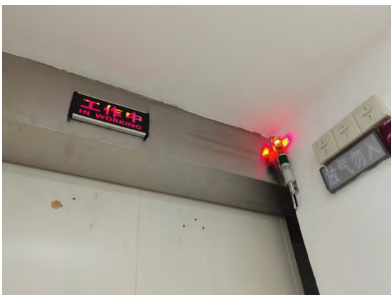
回旋加速器机房防护门上方指示灯
