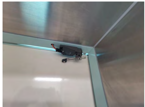
医护人员进出防护门上方联锁装置
