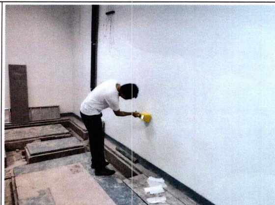
加速器室南侧表面污染检测点
